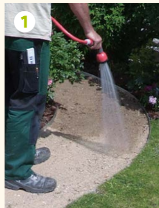
Schottertragschicht anfeuchten
